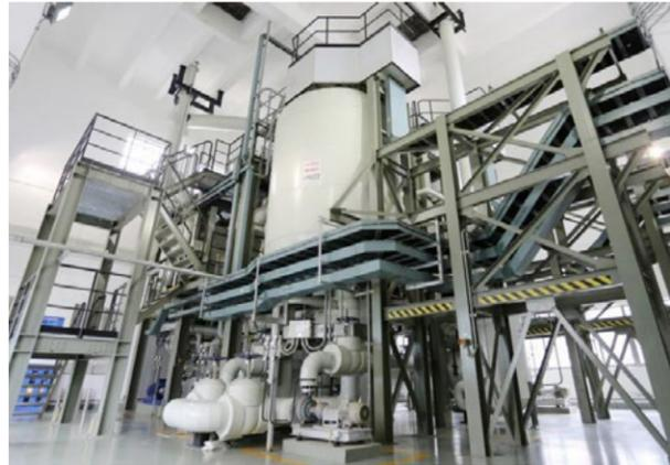
高压电极蒸汽锅炉
